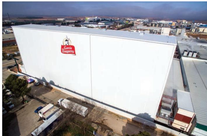
▲ AR Racking realisierte das HRL für García Baquero in Silobauweise mit einem 36m hohen Regalsystem – bei der Silobauweise stellt das Regalsystem einen Teil der Gebäudestruktur dar.
