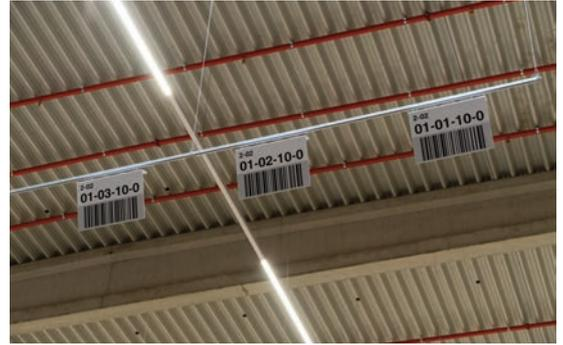
▲ Im Blocklager hat das Montageteam von ONK die Schilder mittels einer speziellen Konstruktion von der Hallendecke abgehängt. Sie ‚schweben‘ über dem jeweiligen Stellplatz und lassen sich aufgrund der Konstruktion jederzeit umhängen, wenn sich die Anordnung der Ware ändert. Für eine bessere Lesbarkeit sind die Schilder zum einen abgewinkelt. So hängen sie nicht senkrecht über dem Boden. Zum anderen ist der Barcode auf retroreflektierende Folie gedruckt.
