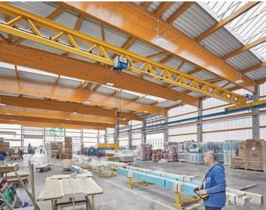
▲ Mehr Helligkeit auf der Arbeitsebene: Das lichtdurchlässige Trägerprofil des V-Profilkrans fügt sich in die Hallenstruktur ein.
