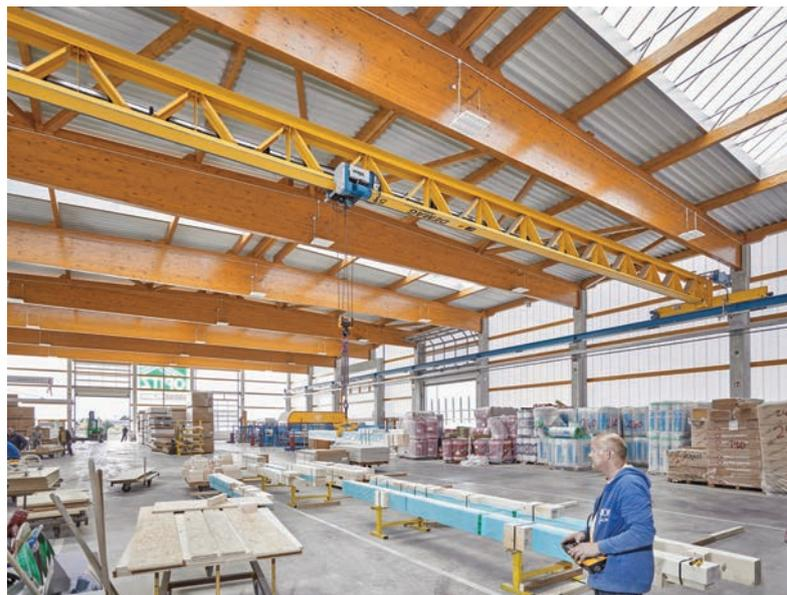
▲ Mehr Helligkeit auf der Arbeitsebene: Das lichtdurchlässige Trägerprofil des V-Profilkrans fügt sich in die Hallenstruktur ein.
