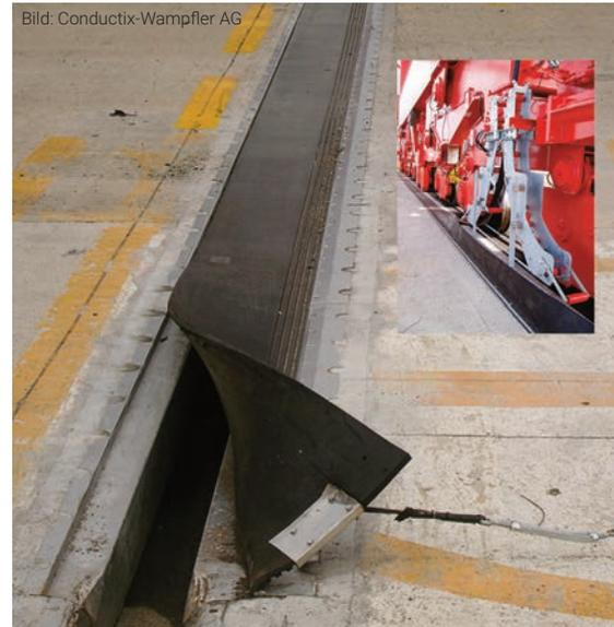
▲ Der Leitungsschacht wird durch das TrenchGuard-System von Conductix-Wampfler vor mechanische Belastungen sowie vor Umweltbedingungen, Rieselgut oder anderen Materialien und Gegenständen, die in den Kanal gelangen könnten, geschützt.
