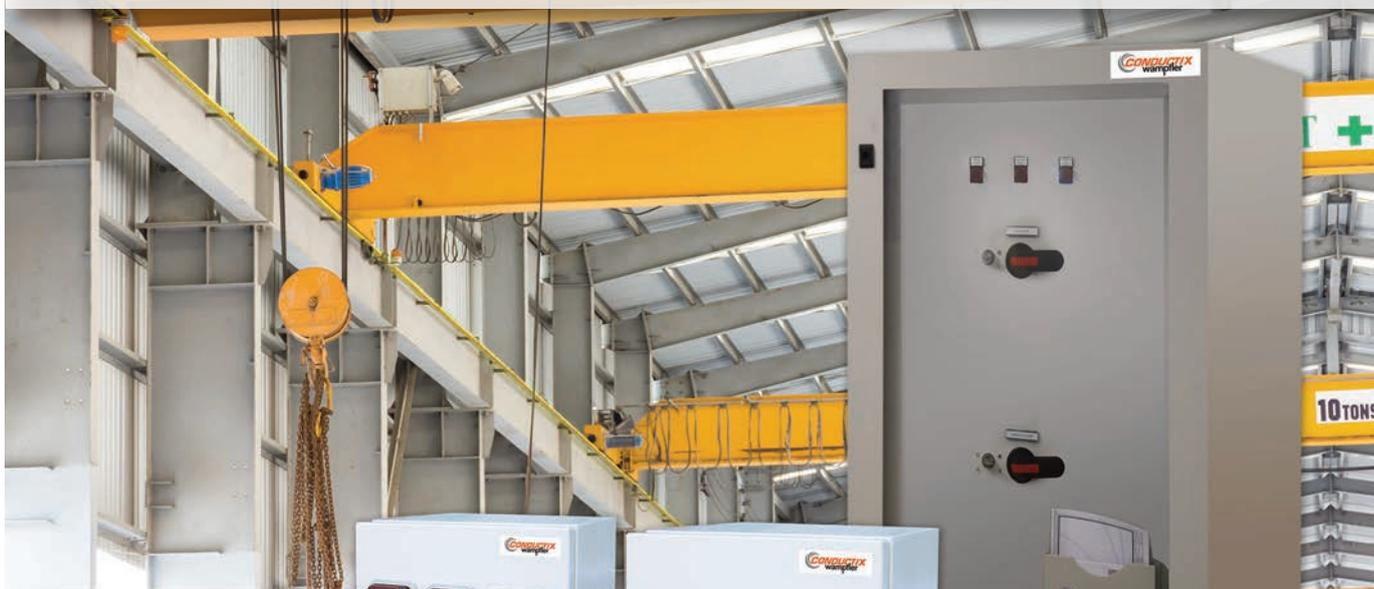
▲ Die Systemlösung PowerGuard 0800 von Conductix-Wampfler ermöglicht es, einzelne Verbraucher auf einer Schleifleitungsstrecke sicher und einfach spannungsfrei zu schalten und zu erden.
