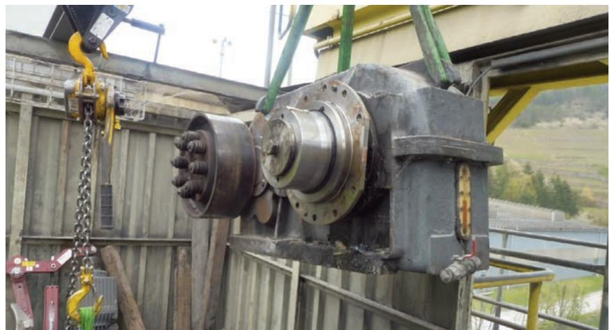
Mit einer zu Ende gehenden Restnutzungsdauer des Kranhubwerks sah sich Heidelberg Materials am Standort Lengfurt konfrontiert. Im Bild: der Ausbau des alten Hubwerksgetriebes.
