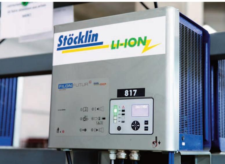
▲ Bei dem Lithium-Ionen-Energiesystem LiFePO4 von Stöcklin handelt es sich um ein speziell entwickeltes aktives Balancing-Verfahren, das die gesamte Kapazität aller Zellen nutzt, um die maximal mögliche Ladung entnehmen zu können.
