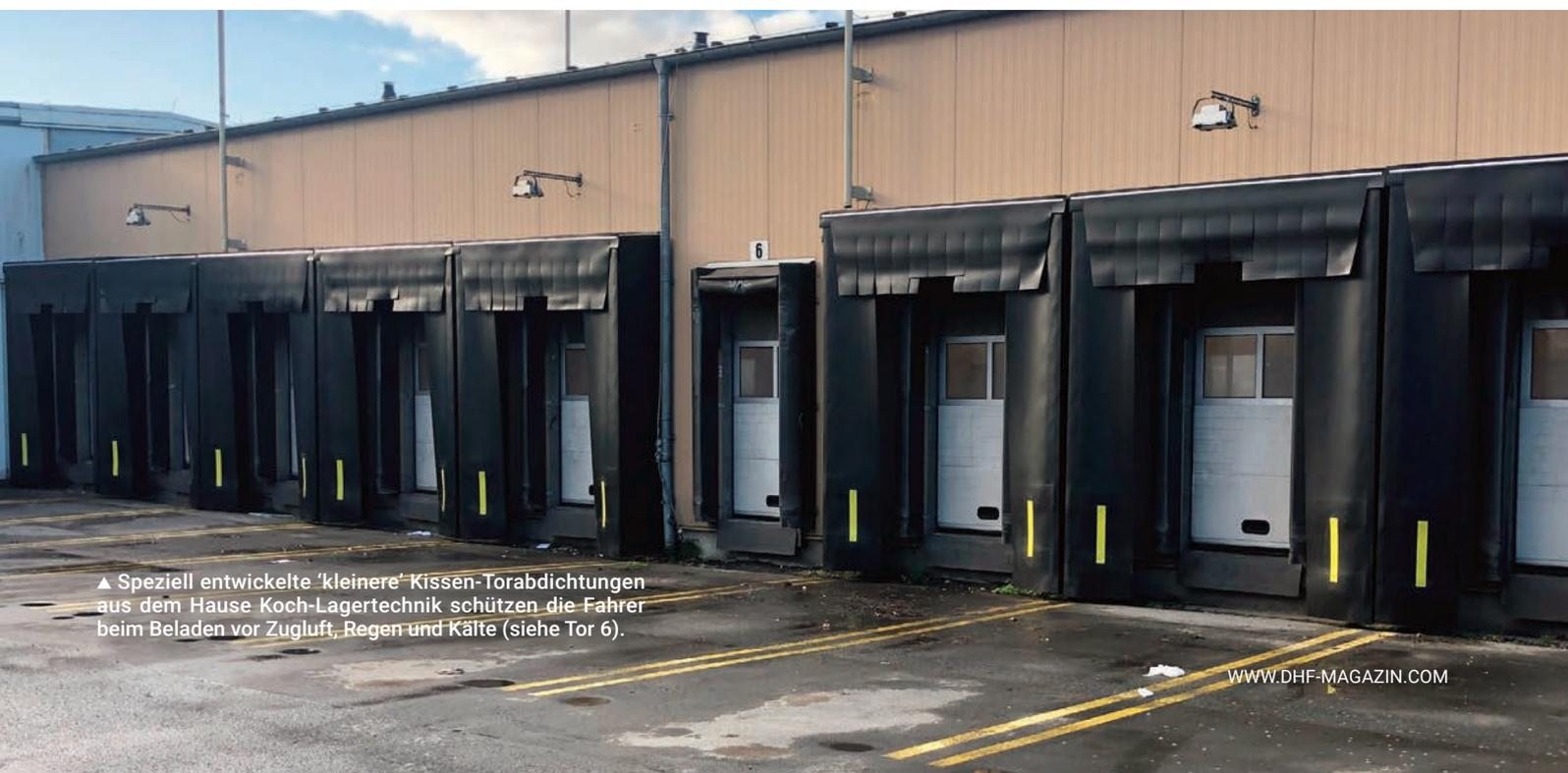
▲ Speziell entwickelte 'kleinere' Kissen-Torabdichtungen aus dem Hause Koch-Lagertechnik schützen die Fahrer beim Beladen vor Zugluft, Regen und Kälte (siehe Tor 6).
