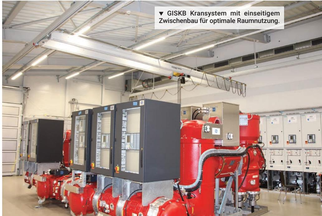
▼ GISKB Kransystem mit einseitigem Zwischenbau für optimale Raumnutzung.
