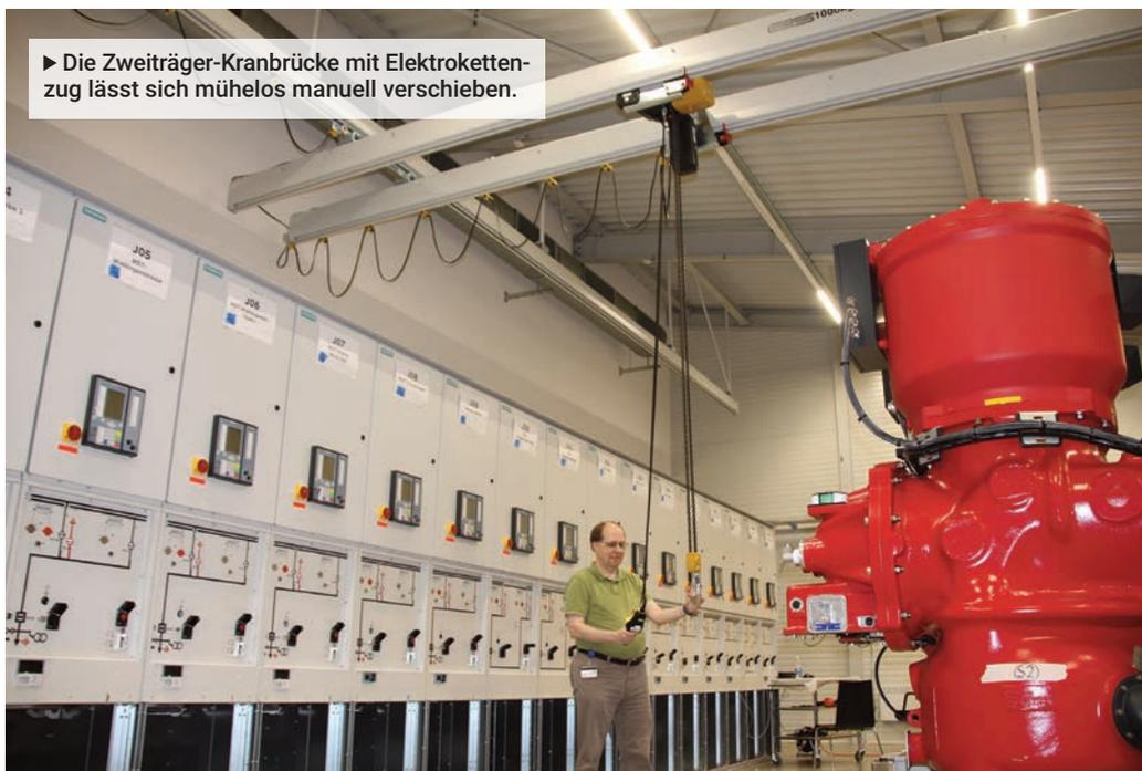
► Die Zweiträger-Kranbrücke mit Elektrokettenzug lässt sich mühelos manuell verschieben.
