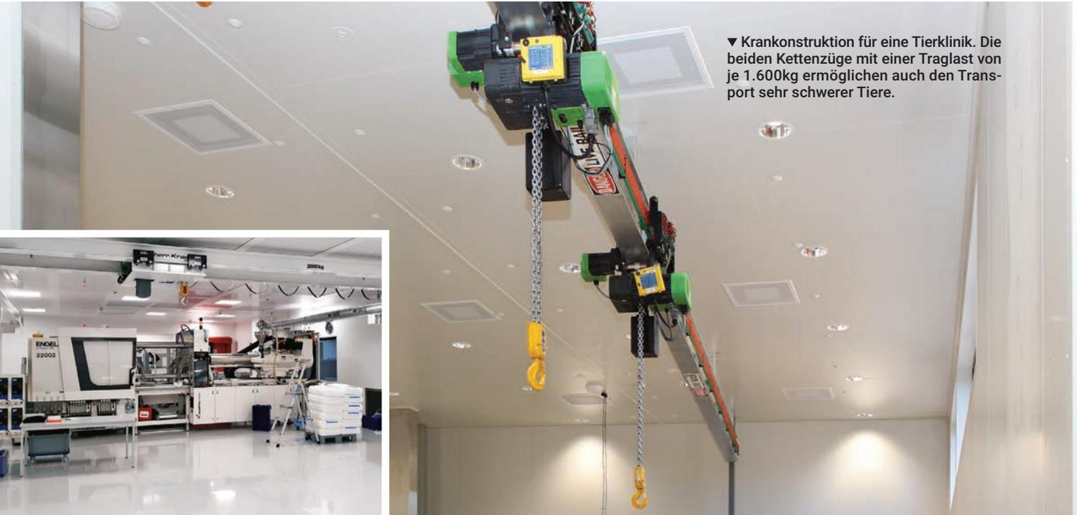
▼ Krankonstruktion für eine Tierklinik. Die beiden Kettenzüge mit einer Traglast von je 1.600kg ermöglichen auch den Transport sehr schwerer Tiere.
