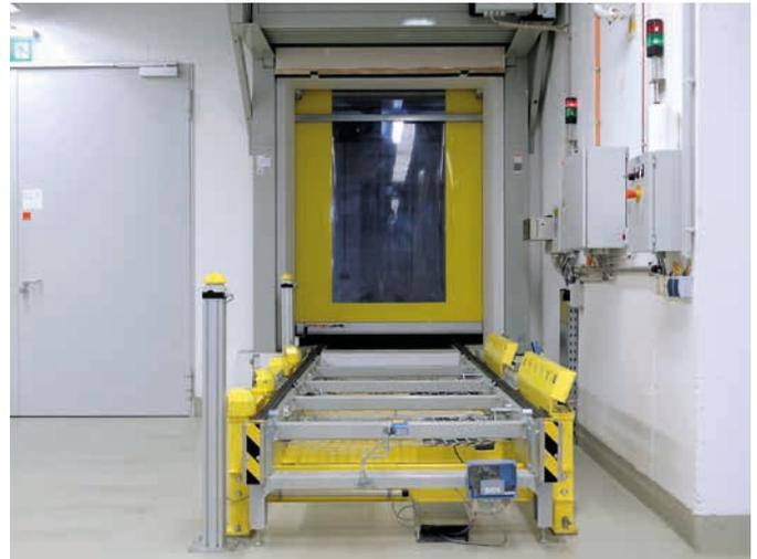
▲ In den Produktionsbereichen von Bayer Weimar kommen zur Trennung der Reinräume von den Gängen Schnelllaufrolltore EFA-SRT CR von Efaflex zum Einsatz (Foto: Efaflex)
